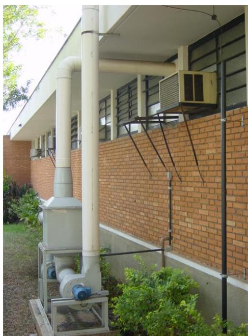
**Figura 12.** Lavador de gases para vapores orgânicos
