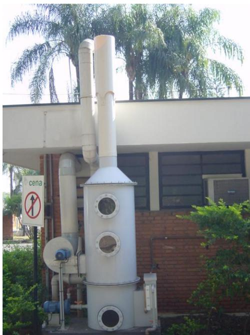
**Figura 11.** Lavador de gases para vapores ácidos
